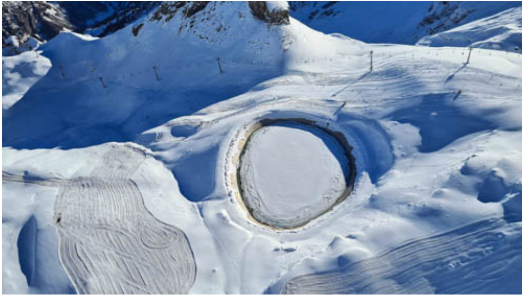
Abb. 14: Entleerter künstlicher Beschneungsspeicher. Foto: Bruno Petroni
